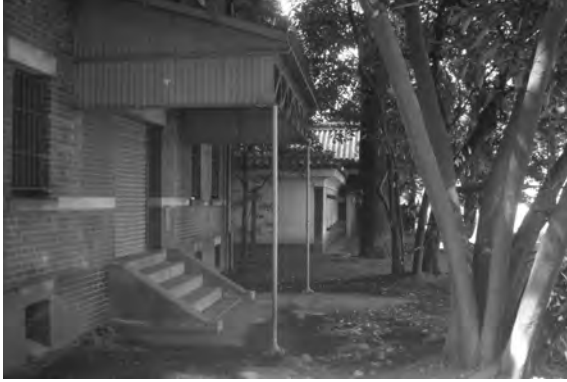
5図 工事前の状況(3月)
