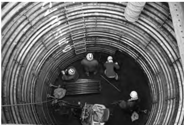
6図 トレンチ1 作業風景
