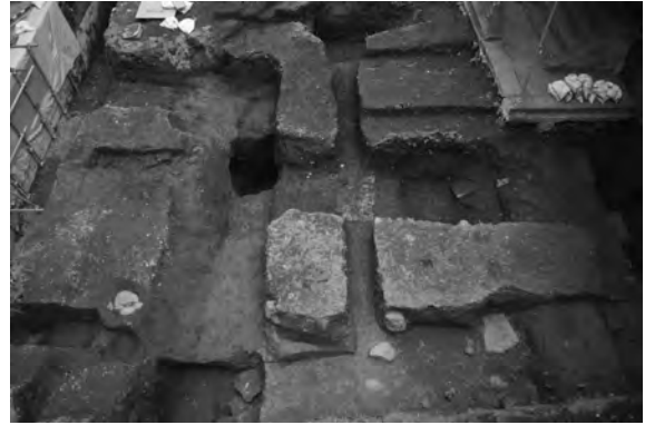
8図 渡り廊下及び旧東京医学校本館 移築時の基礎掘方
