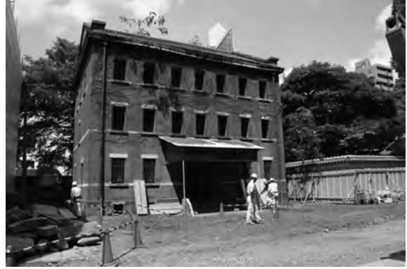
6図 調査開始前の状況 (写真左は渡り廊下を含む除去された縁石)
