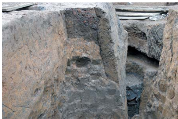
写真 53 SU824 豎坑南壁補強部断面
