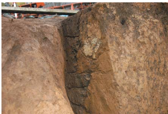
写真 54 SU824 豎坑北壁補強部断面
