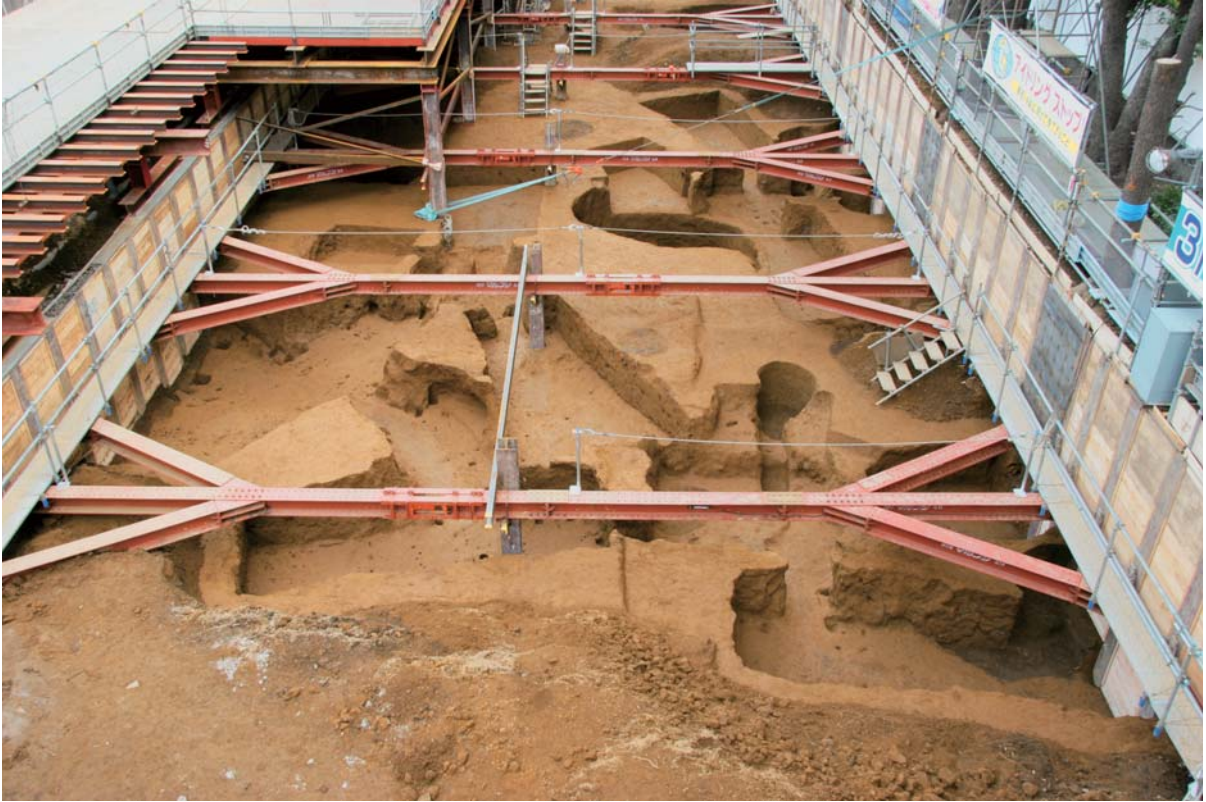
口絵 1 情報学環・福武ホール地点地下式麴室群
