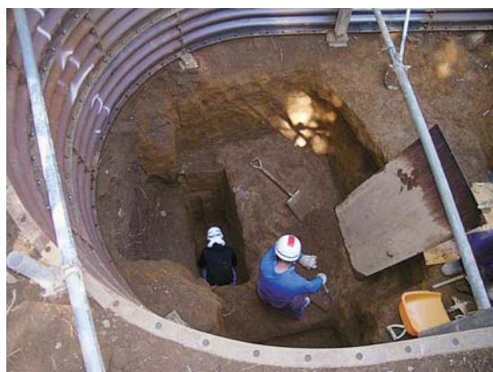
写真9 遺構掘削作業
