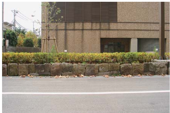
写真 5 築石再利用状況 2
