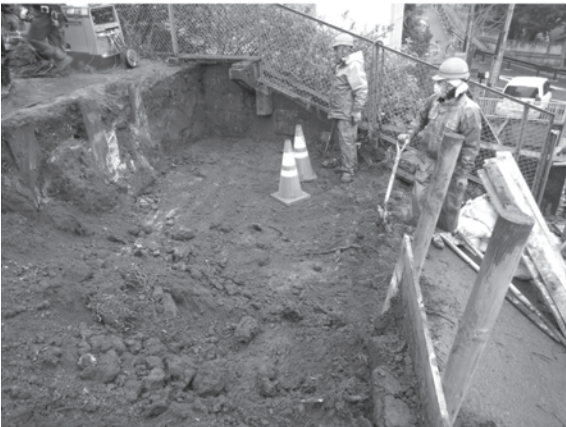
31図 C区掘削状況1（南東から）
