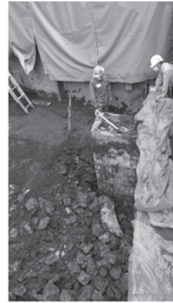
36図 C区排水柵検出状況 (南東から)
