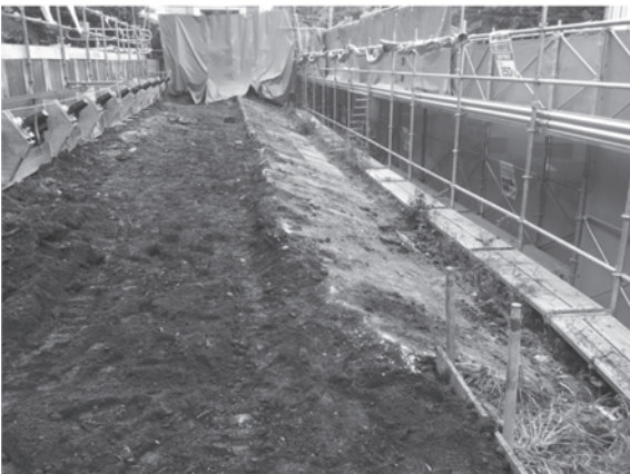
33図 C区コンクリート土間検出状況（南東から）
