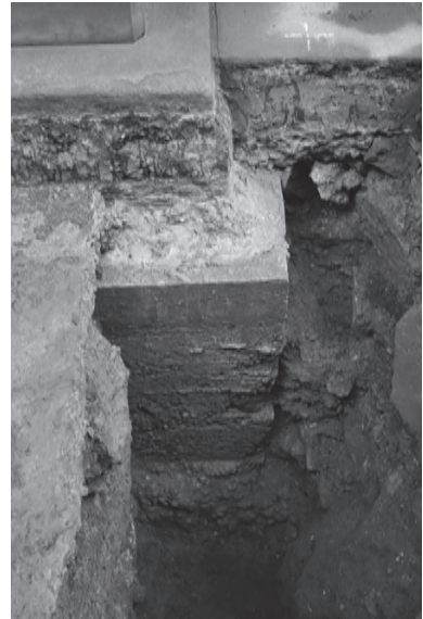
8図 コンクリート基礎外面
