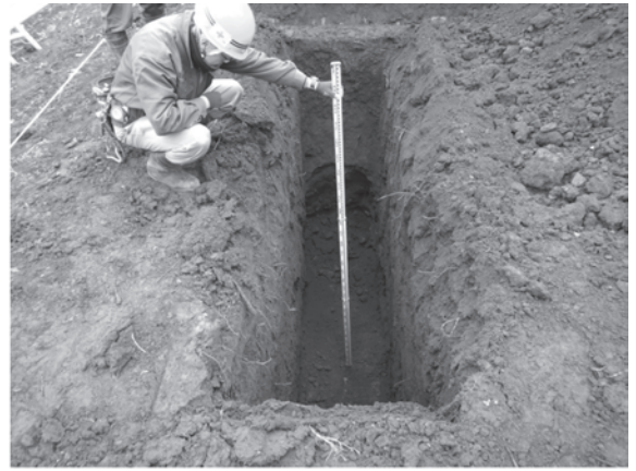
28図 B区掘削状況1（北西から）
