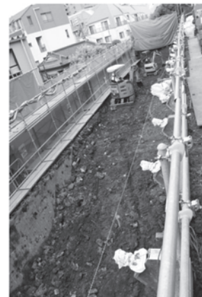
34図 C区掘削状況3（北西から）
