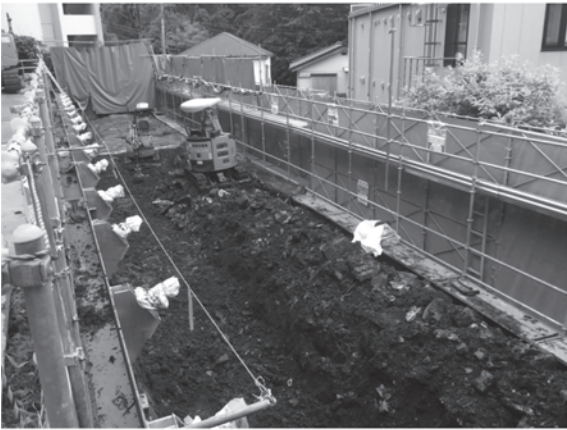
35図 C区掘削状況4 (南から)
