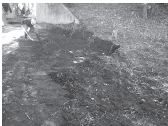
13図 A2区立会状況（南東から）
