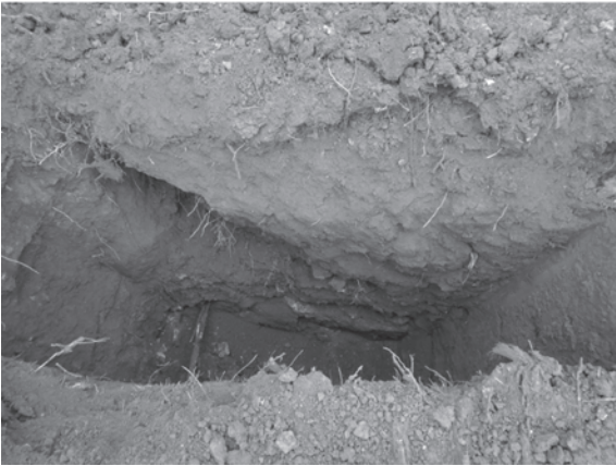
29図 B区掘削状況2（北東から）
