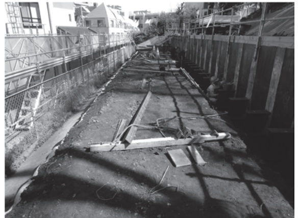
32図 C区掘削状況2（北西から）
