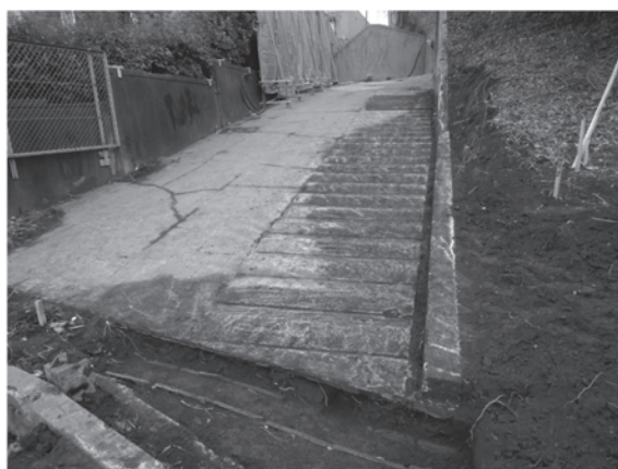
14図 A2区立会状況（南東から）
