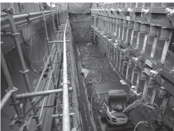
41図 C区掘削状況6 (北から)
