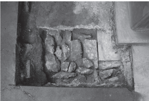
9図 コンクリート基礎周囲の堀方（東から）
