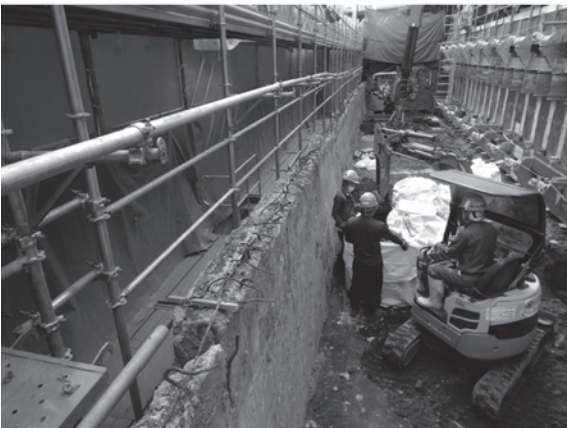
37図 C区擁壁上部検出状況 (北から)
