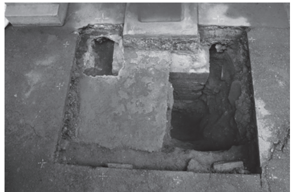
10図 コンクリート基礎の形状
