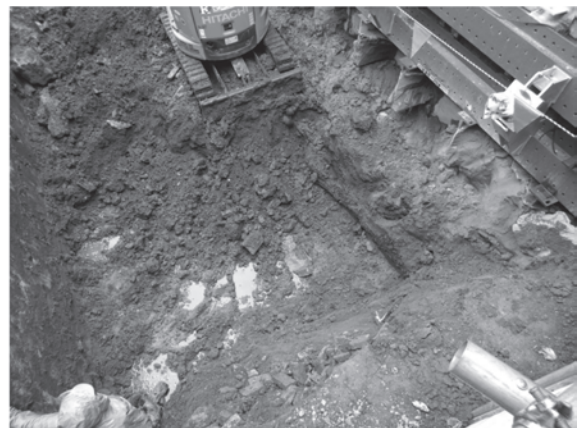
38図 C区掘削状況5 (北西から)
