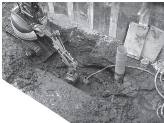
43図 C区浸透柵設置部分掘削状況（北から）
