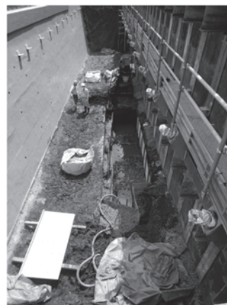
46図 C区浸透柵設置部分掘削状況（北西から）
