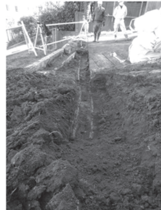
30図 B区掘削状況3（北東から）
