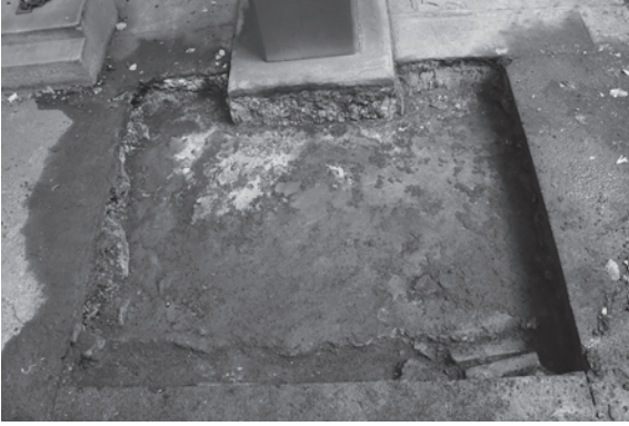
5図 コンクリートのタタキ（南から）
