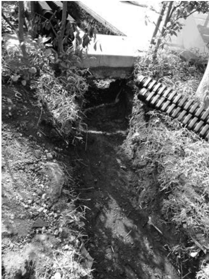
26 図 電気設備地点 G 区西側掘削状況 2 (西から)
