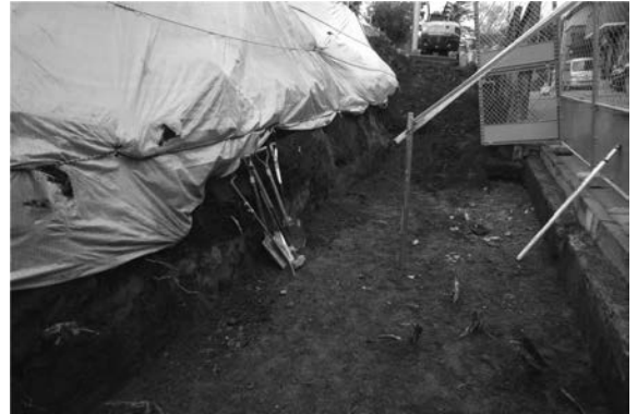
73図 北側囲障改修地点D区西側底面確認状況（東から）
