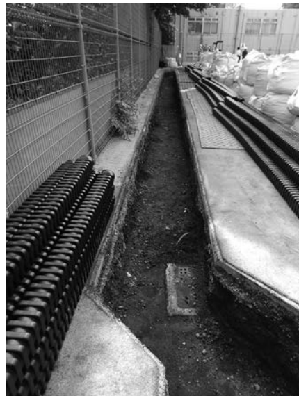
29 図 電気設備地点 G 区東側掘削状況 (西から)
