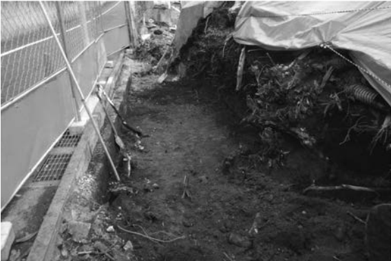
72図 北側囲障改修地点D区東側底面確認状況（西から）
