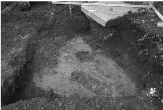
90図 北側囲障改修地点G区②掘削状況（西から）
