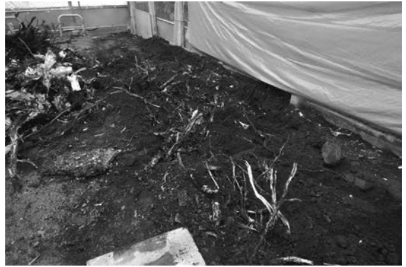
87図 北側囲障改修地点F区掘削状況（南東から）
