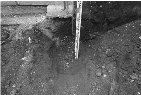
80図 北側囲障改修地点E区万年堀支柱撤去状況2（南から）
