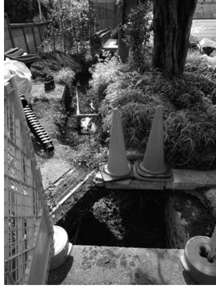
25 図 電気設備地点 G 区西側掘削状況 1 (西から)
