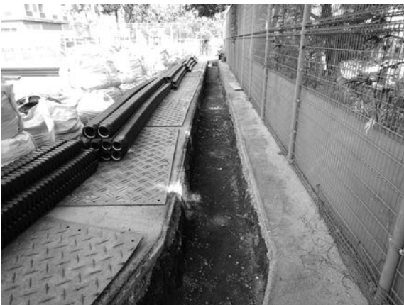
28 図 電気設備地点 G 区東側掘削状況 2 (東から)
