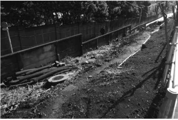
70図 北側囲障改修地点D区調査前状況（南西から）
