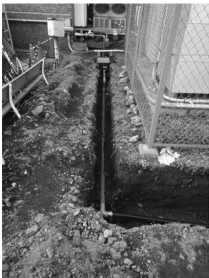
18図 給水管設備地点A区全景（北から）
