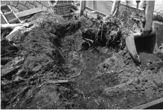
78図 北側囲障改修地点E区抜根状況（南東から）
