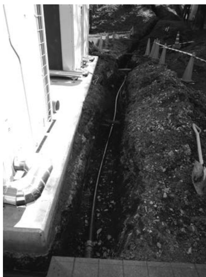
21図 給水管設備地点C区下位段部分全景（西から）
