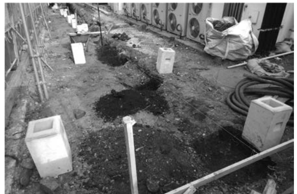
83図 北側囲障改修地点E-2区フェンス基礎掘削状況（北西から）
