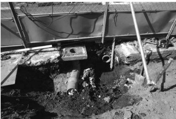
92図 北側囲障改修地点H区①掘削状況（南から）
