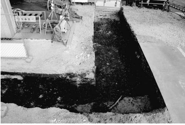
3図 完掘状況(西から)
