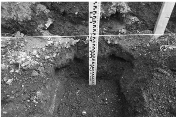
84図 北側囲障改修地点E-2区フェンス基礎完掘（北から）
