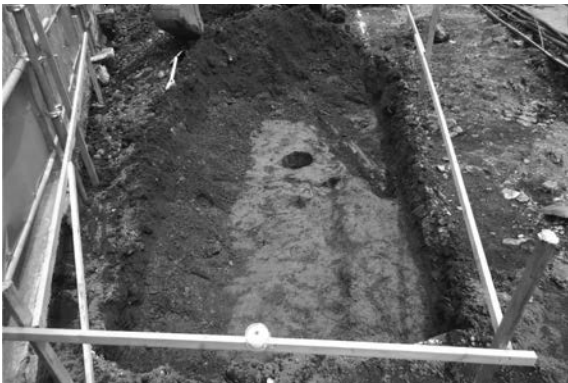
88図 北側囲障改修地点G区①掘削状況（西から）
