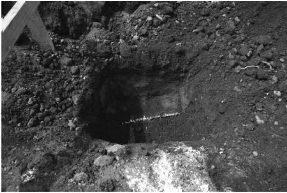
86図 北側囲障改修地点E-2区フェンス基礎掘完堀（北から）
