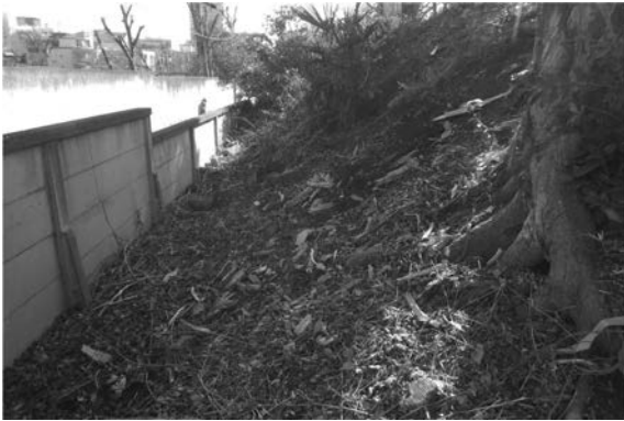
64図 北側囲障改修地点C区調査前状況（西から）
