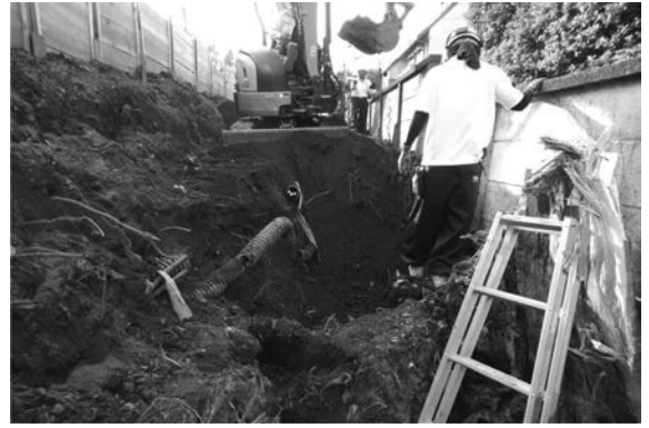
71図 北側囲障改修地点D区掘削状況（東から）
