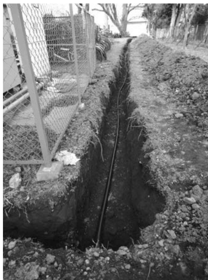
19図 給水管設備地点B区全景（東から）
