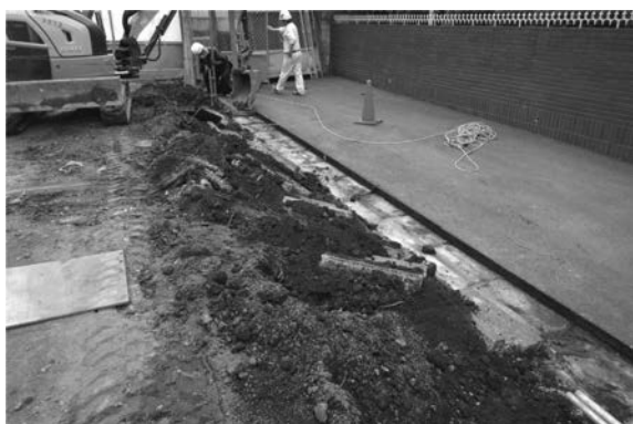
96図 北側囲障改修地点H区西側掘削状況（南東から）
