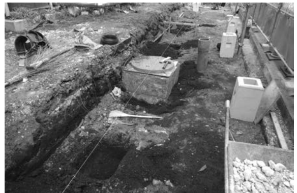
85図 北側囲障改修地点E区東側掘削底面確認状況（東から）
