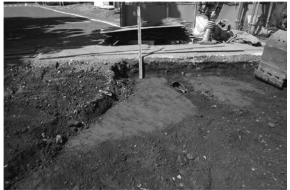
91図 北側囲障改修地点G区掘削状況（北東から）
