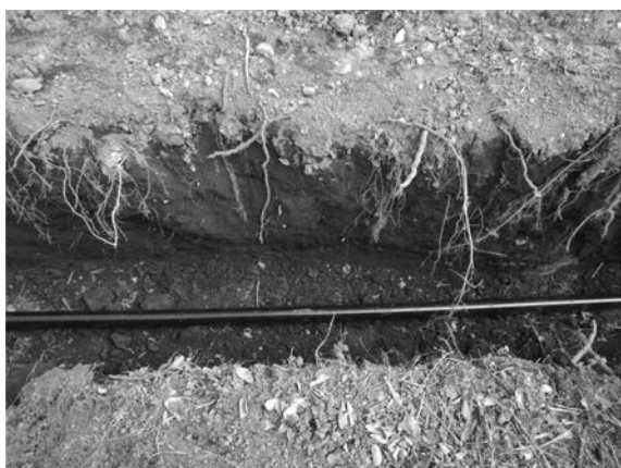
20図 給水管設備地点B区①堆積状況（北から）
