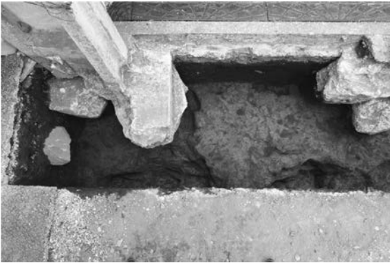
56図 北側囲障改修地点A-1区SX20完堀（南から）
