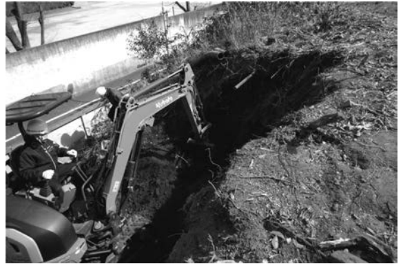
65図 北側囲障改修地点C区掘削状況（南西から）
