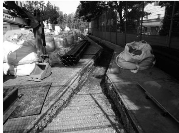
27 図 電気設備地点 G 区東側掘削状況 1 (東から)
