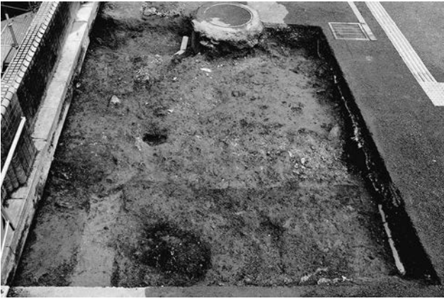
図3 調査区南側掘削状況(南から)
