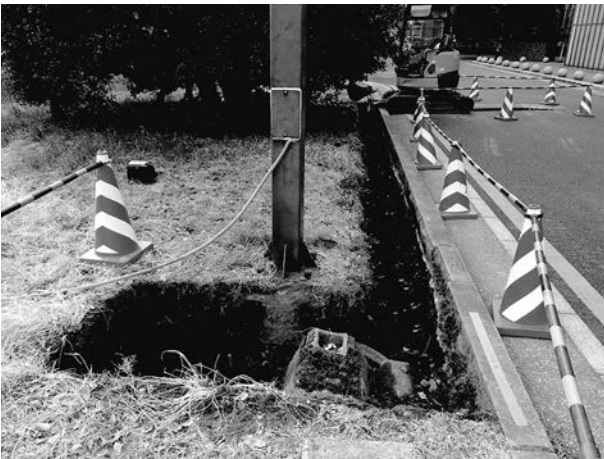
3 図 1区掘削状況
