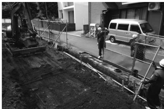
95図 北側囲障改修地点H区東側掘削状況（南東から）
