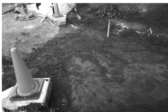
99図 北側囲障改修地点I区南側掘削状況（西から）
