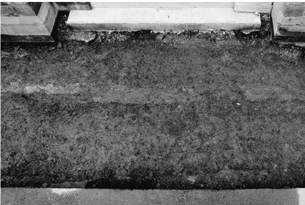
図5 調査区中央部掘削状況(東から)
