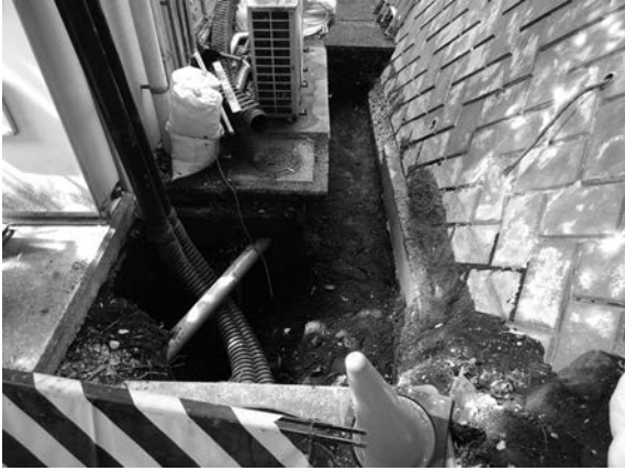
24 図 電気設備地点 F 区掘削状況 (北から)
