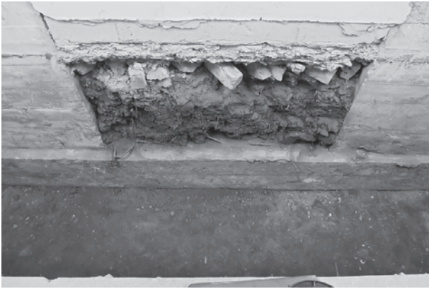
3図 補強壁1全景
