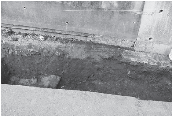
25 図 8区土層堆積状況
