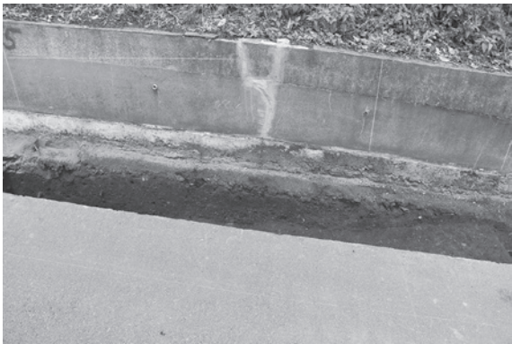
17 図 5 区土層堆積状況
