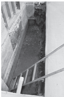
5図 補強壁2全景
