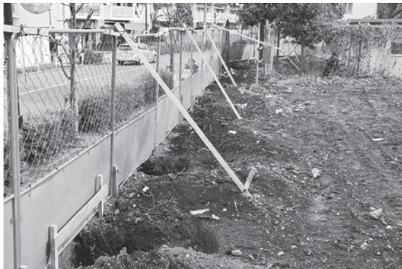
9 図 3 区トレンチ (西から)
