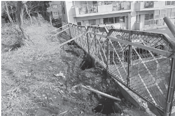
13図 4区トレンチ (南から)
