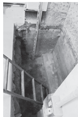
8図 補強壁6全景
