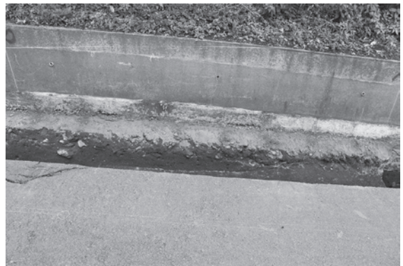
14 図 4 区土層堆積状況
