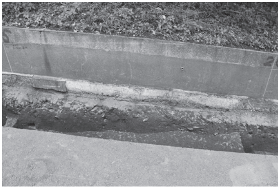
11 図 3 区土層堆積状況
