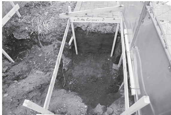
3 図 1区北側トレンチ (西より)
