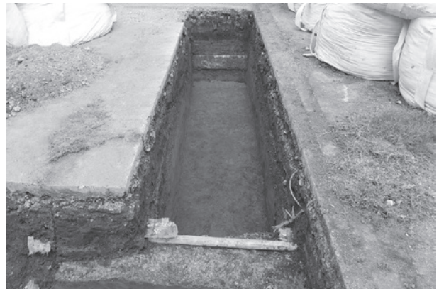
11図 トレンチ18全景(西から)
