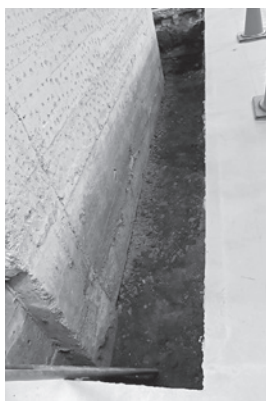
9図 補強壁7全景
