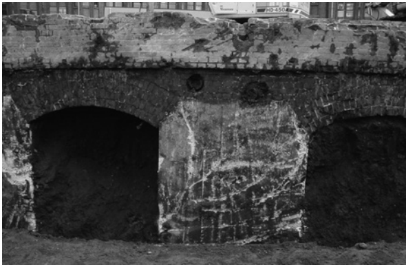
4図 建物1東側北壁基礎の状況2
