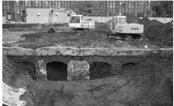
3図 建物1東側北壁基礎の状況1
