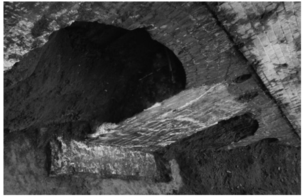
5図 建物1東側北壁基礎の状況3
