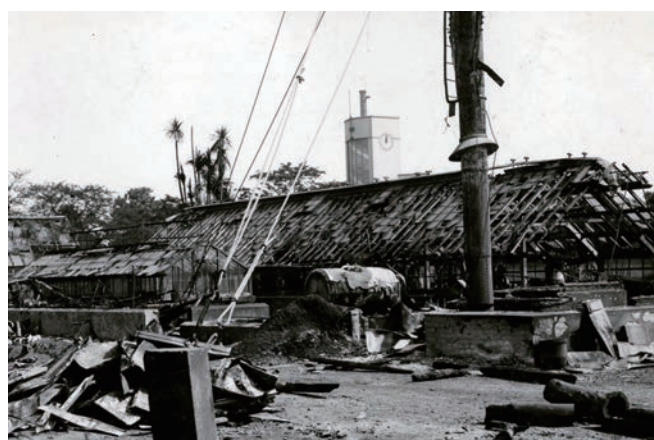
21 図 山手空襲 (昭和 20 年 5 月) で被災した温室 (総合研究博物館所蔵、部分)
