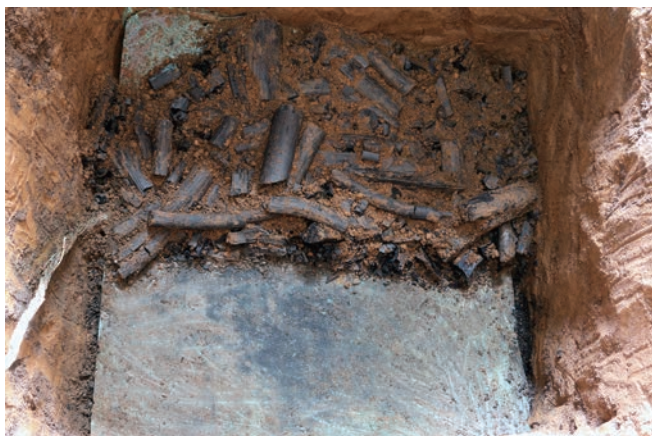
15 図 検出された避雷接地銅板と炭化材 (13 図煉瓦下緑部分、写真手前は炭化材を外し銅版を露出させた状態)
